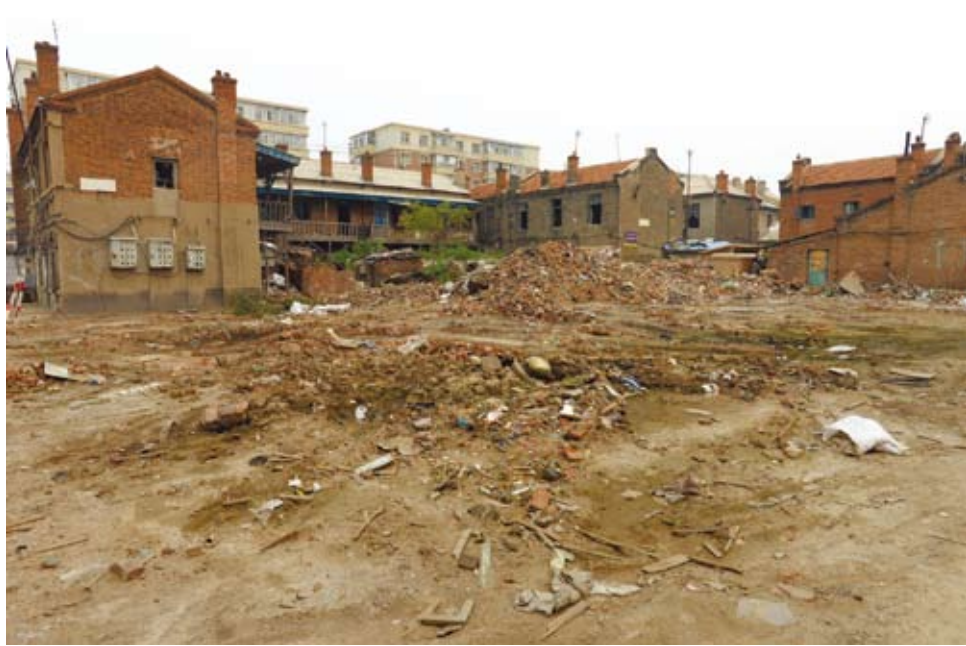
南關區待拆舊樓
